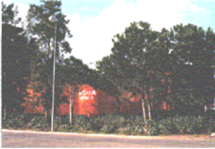
Vista general de las instalaciones del centro, integradas paisajísticamente
